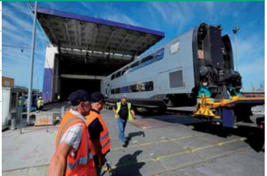
Construcción de la primera línea de tren de alta velocidad en Marruecos. /XAVIER LEOTY/AFP/GETTY IMAGES
